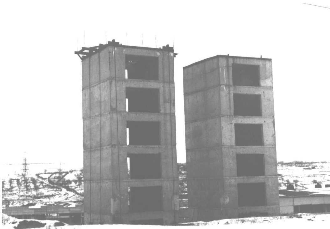
Fig.8. Fragmentele 1 și 2 cu pereții structurali de beton armat
