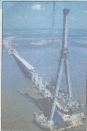
Le pont de Normandie relie Le Havre à Honfleur au-dessus de l'estuaire de la Seine. Paramètres: 42 km de câbles métalliques, 2 piliers de 214 m de haut, 164 haubans.
