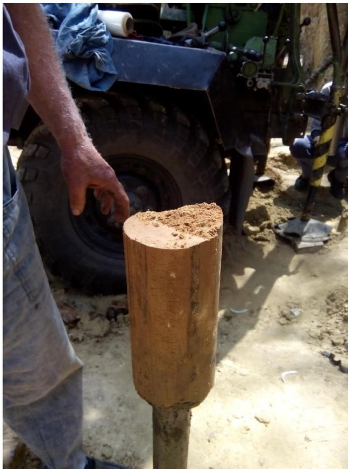
Рис. 2.7. Отбор монолита для испытаний в лаборатории
