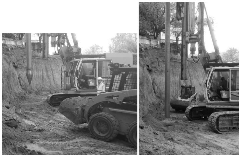
Рис. 3.7. Устройство грунтовых свай с помощью RG установки
