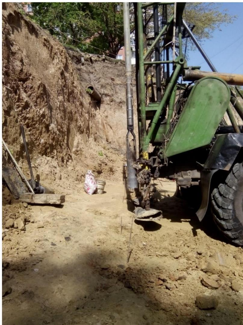
Рис. 1.5. Вертикальный откос в толще просадочного суглинка.
