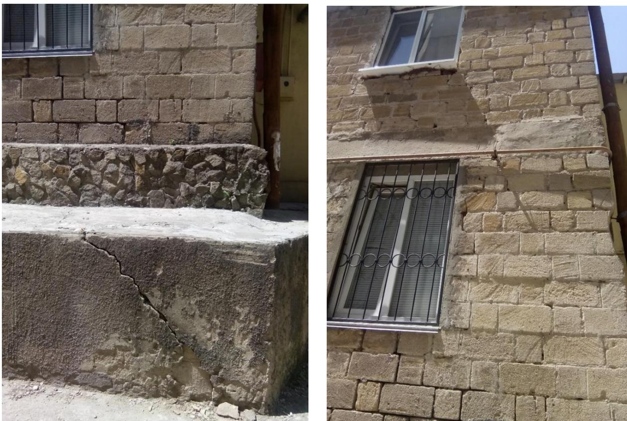
Рис. 1.6. Трещины в усилении цоколя и стене жилого дома, возникшие в результате просадки грунтов основания. Кишинэу, сектор Боюкань, ул. Алдя-Теодорович
