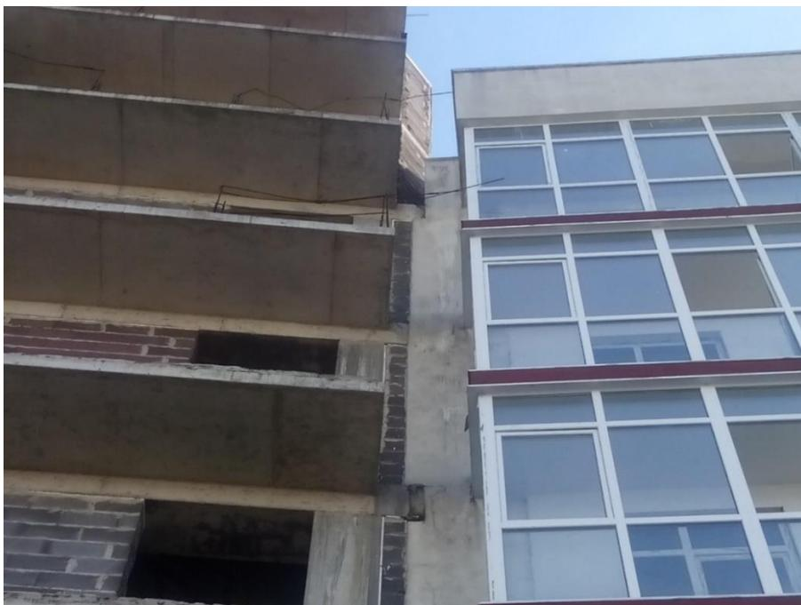
Рис. 2.1. Неравномерные деформации недостроенного здания
