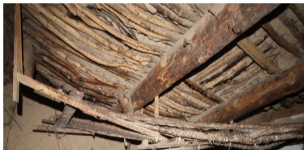
Figura A3.3.1. Tehnica de construcții „паянтов градеж”, foto autor, 2018. S. Stoianovca, raionul Cantemir
