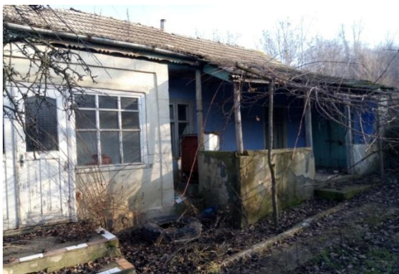
Figura A3.7.4. Casa tradițională cu beci sub casă, construită anii 1950-ci, proprietar actual Peicova M., s. Stoianovca, raionul Cantemir. Foto autor, 2018
