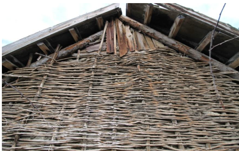
Figura A3.4.2. Frontonul acoperișului unei construcții gospodărești executat în tehnica „паянтов градеж”, foto autor, ianuarie 2018. S. Stoianovca, raionul Cantemir
