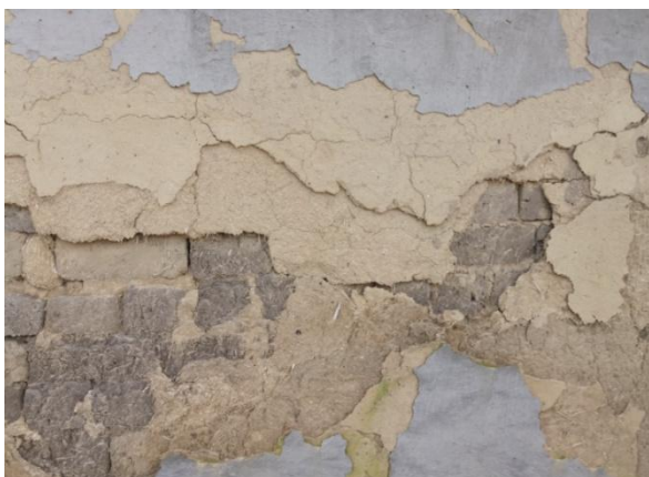
Figura A3.3.4. Pereți de casă ridicate cu lampaci (chirpici nears), unse cu 2 straturi de lut și date cu var, foto autor, ianuarie 2018. S. Stoianovca, raionul Cantemir
