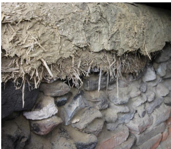
Figura A3.3.2. Pereți ridicate în diferite tehnici și unse cu lut, foto autor, 2018. S. Stoianovca, raionul Cantemir
