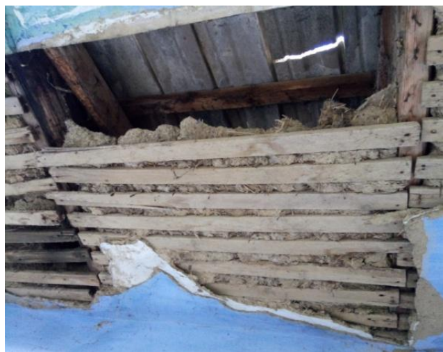
Figura A3.3.2. Pereți ridicate în diferite tehnici și unse cu lut, foto autor, 2018. S. Stoianovca, raionul Cantemir
