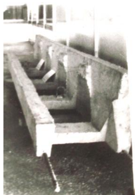
Fig. 6. Prototipul centurii PrMn din blocuri prefabricate ( Tipul 1 ), prezentat la expoziția din Moldova, la care modelul autorului a obținut cel de-al doilea premiu. [Foto de autor, la ВДНХ МССР].
