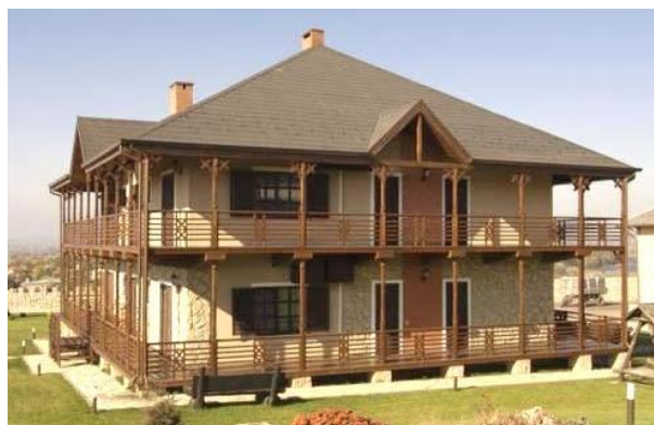
Figura A4.73. Vila Nord. Fațadă
