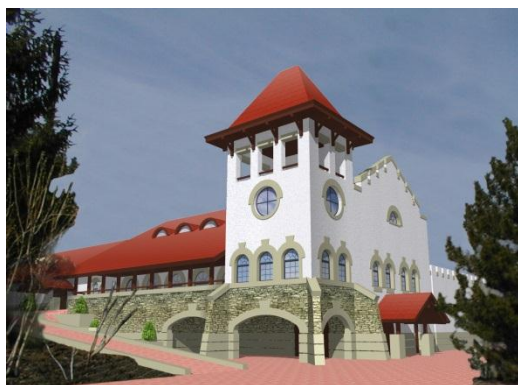
Figurile A4.8, 4.9. Clădirea existentă deasupra beciului până la reconstrucție
