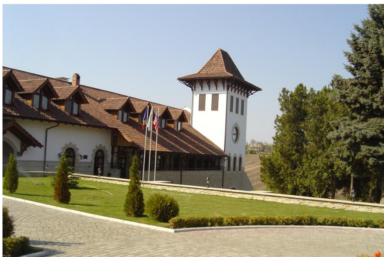
Figura A4.14. Vedere spre turnul clădirii din curtea interioară
