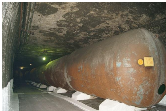
Figura A3.86. Secția de maturare a vinurilor în cisterne
