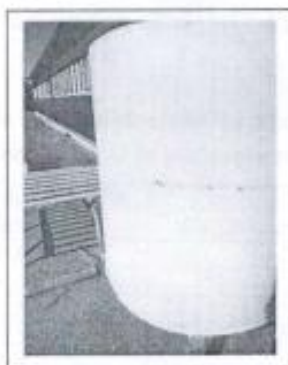
Fig. 1.1 Instalația combinată cu frig natural și artificial pentru răcirea laptelui utilizat la Complexul Didactico-Experimental al UASM
