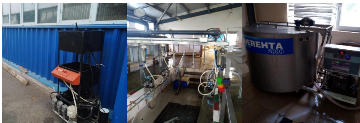
Fig. 1.3 Instalația frigorifică combinată pentru răcirea laptelui cu frig natural (a) și artificial (b)
