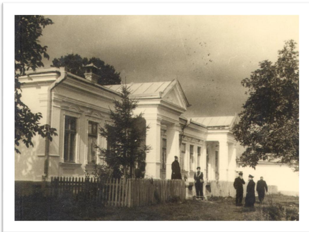
Figura 10. Mănăstirea Hârbovăț. Casa episcopului, 1948. Sursă: Colecția foto M. Brihuneț
