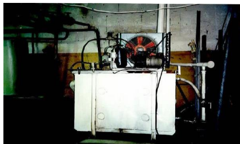
Fig. 11 Instalație combinată cu frig natural și artificial (ferma din s. Corbu, r-nul Dondușeni).
