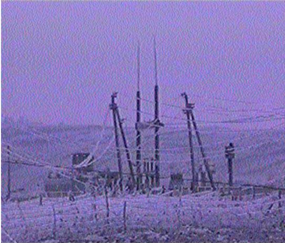
**Рисунок 1.18. Обледенение на электрических и телекоммуникационных проводах<sup>30</sup>**
